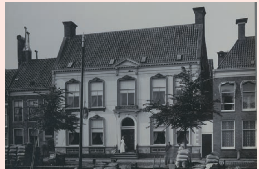
Schuitendiep 39 (voorheen 21), woonhuis van de freules Feith, Groningen, ca. 1905 Uitsnede foto P. Kramer, collectie RHC Groninger Archieven (1785-13936)
