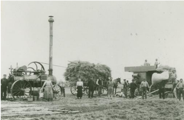
Foto boven: Een dorsmachine aangedreven door een stoommobiel (rond 1895-1900) bij het gehucht Panser tussen Zoutkamp en Vierhuizen. Bron/foto: H. Hes, Groninger Archieven (818-12505).
